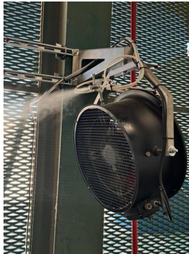
Ventilateur 6 700 m 3 /h avec buse de vaporisation
