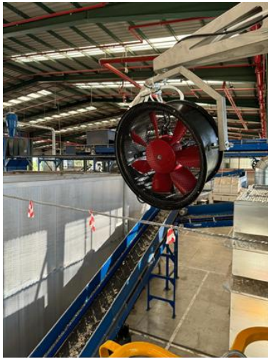
Ventilateur 6 700 m 3 /h avec buse de vaporisation
