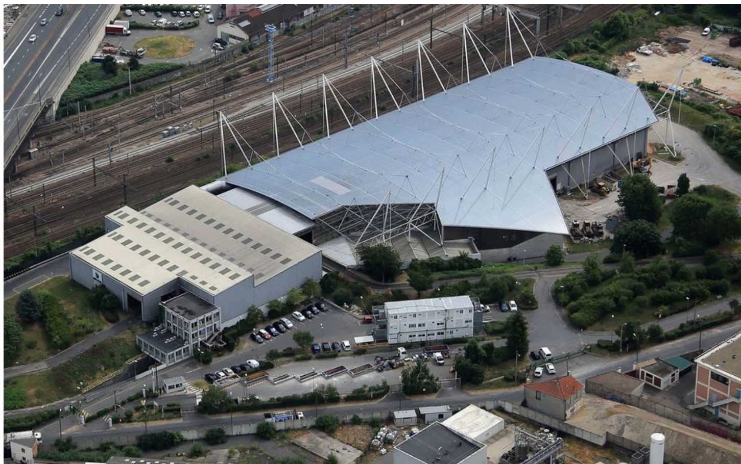
Romainville. La modernisation du centre de tri des déchets devrait débuter en 2022. 4Vents
